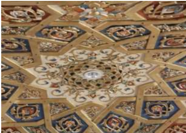
صورة (29)، نموذج لسقف ذو طابع إسلامي تم طباعة أجزاؤه ( حشواته الداخلية) بتقنية الطباعة ثلاثية الأبعاد باستخدام خيوط بلاستيك ( ABS ) سمكها 5 مم ، تم تقسيمه لأجزاء صغيرة حتى يمكن طباعته ثم تم تجميعه وتلوينه وتذهيبه ، استغرقت عملية الطباعة 3 أسابيع وعملية التركيب في السقف يومان - عام 2014
